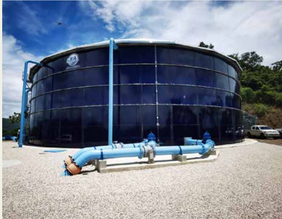
Nuevo acueducto de Nicoya
