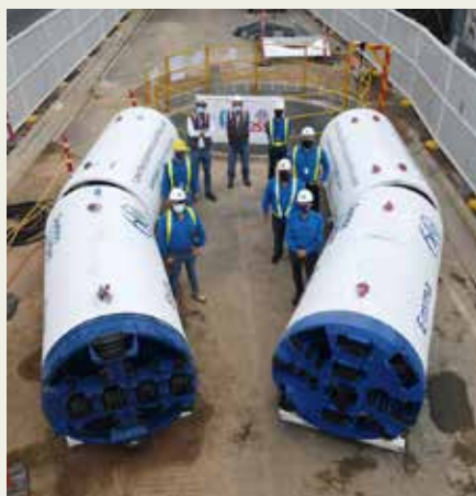
Tuneladoras de alcantarillado
