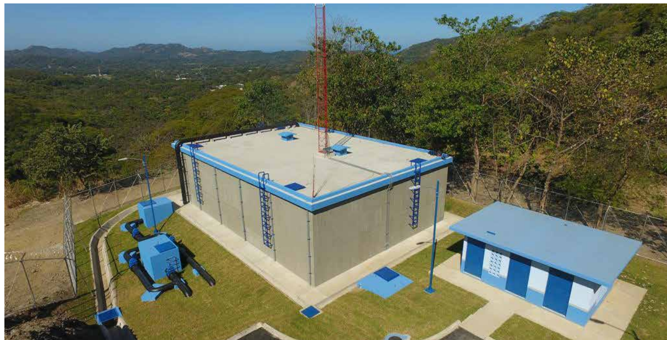
Tanque de Huacas
