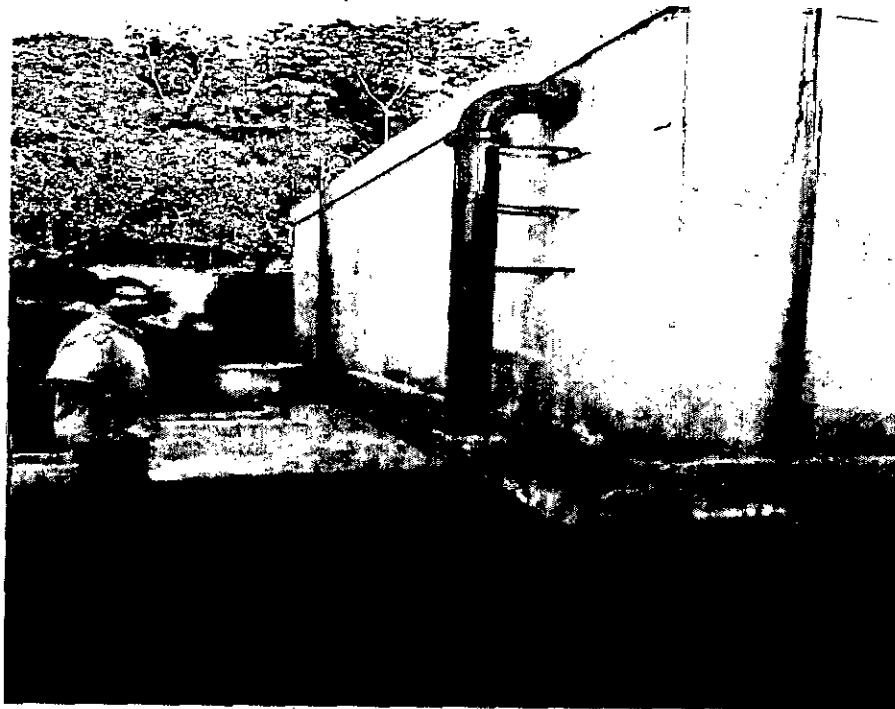
Tanque de almacenamiento
