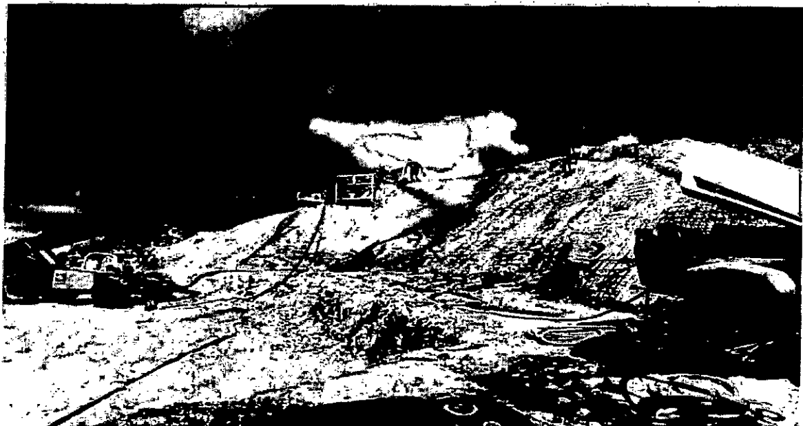
Taludes Obra 2 Brasilito
