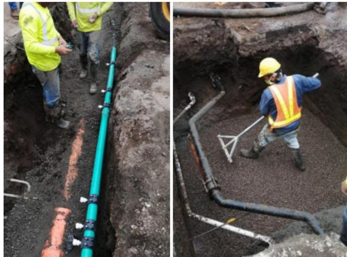
Realineación de tubería de agua potable para dar espacio a las obras sanitarias
