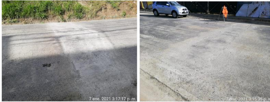
Protección temporal realizada en la superficie de las calicatas excavadas.
