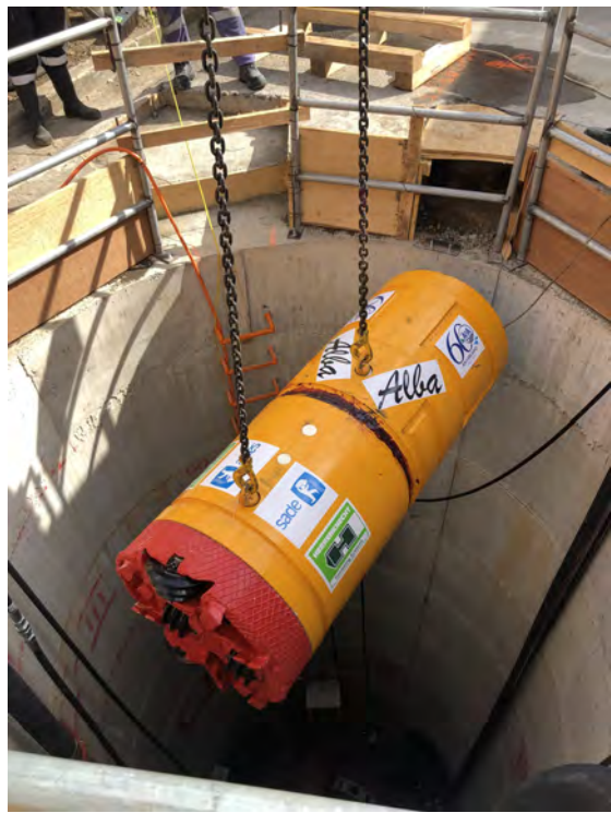
Método microtuneleo
