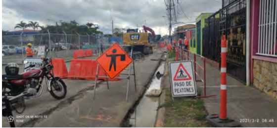
Método de zanja abierta
