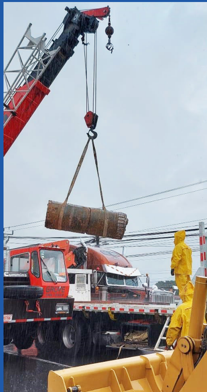
Extracción de cabeza de corte MT-600 mm RN-215
