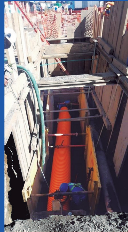
Instalación zanja abierta PVC F-949, 600 mm RN-105
