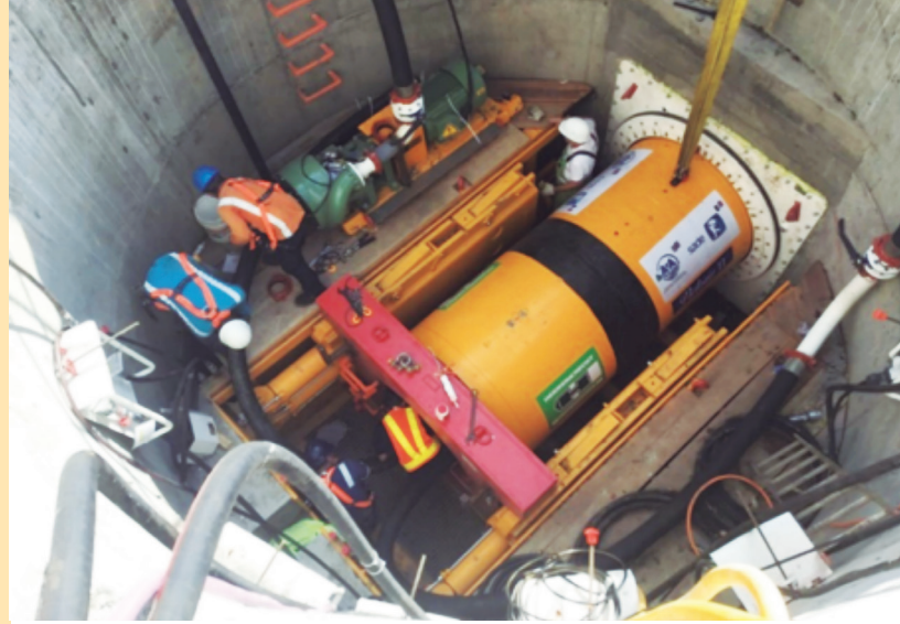
Máquina tuneladora para tubería de 1200 mm.
