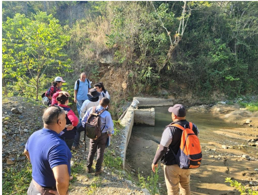
Captación de agua El Matasano.
