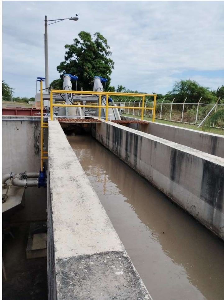
Figura 6: Desarenadores de la PTAR de Granada, Nicaragua
