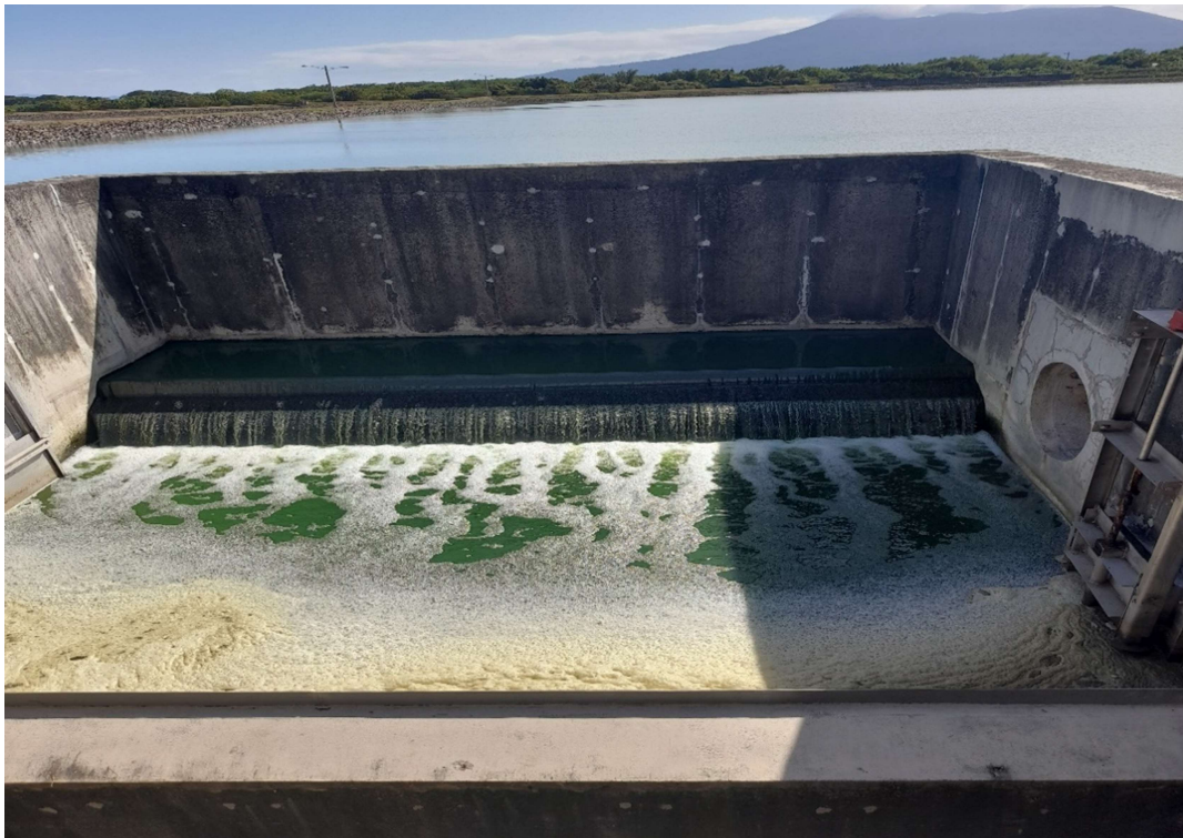
Figura 10: Laguna de maduración en Granada y su efluente
