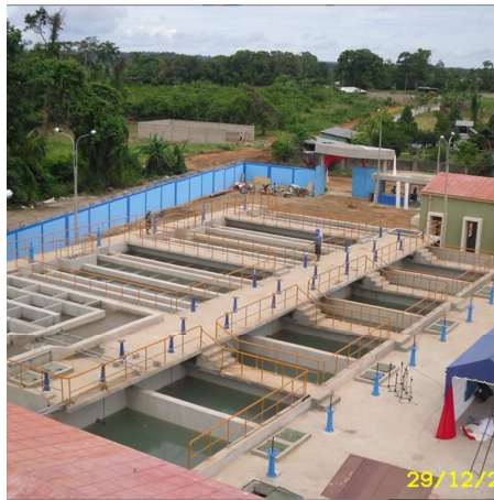
Imagen 1. Toma aérea Planta Potabilizadora la Pastora
