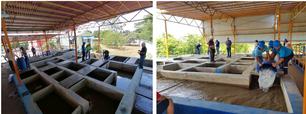
Imagen 4. Floculador de paso vertical y prueba de trazadores en la unidad Fuente: propia
