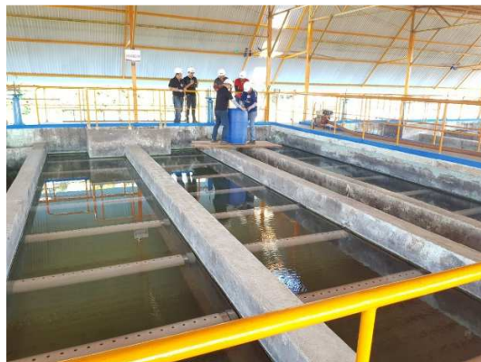
Imagen 5. Decantador de flujo laminar durante la prueba de trazadores Fuente: propia
