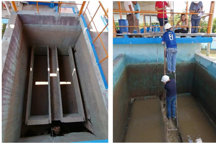
Imagen 6. Evaluación de módulos de filtración.
