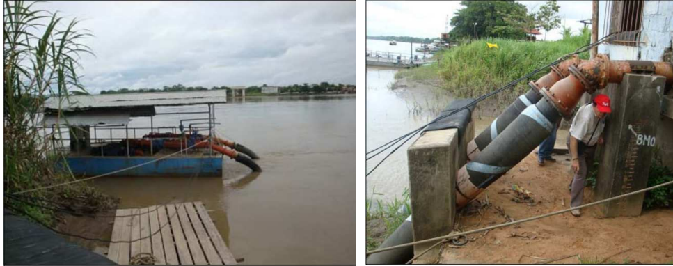
Imagen 2. Captación superficial, mediante sistema de balsa y líneas de impulsión Fuente: Plan Maestro Optimizado 2010-2040. EMAPAT
