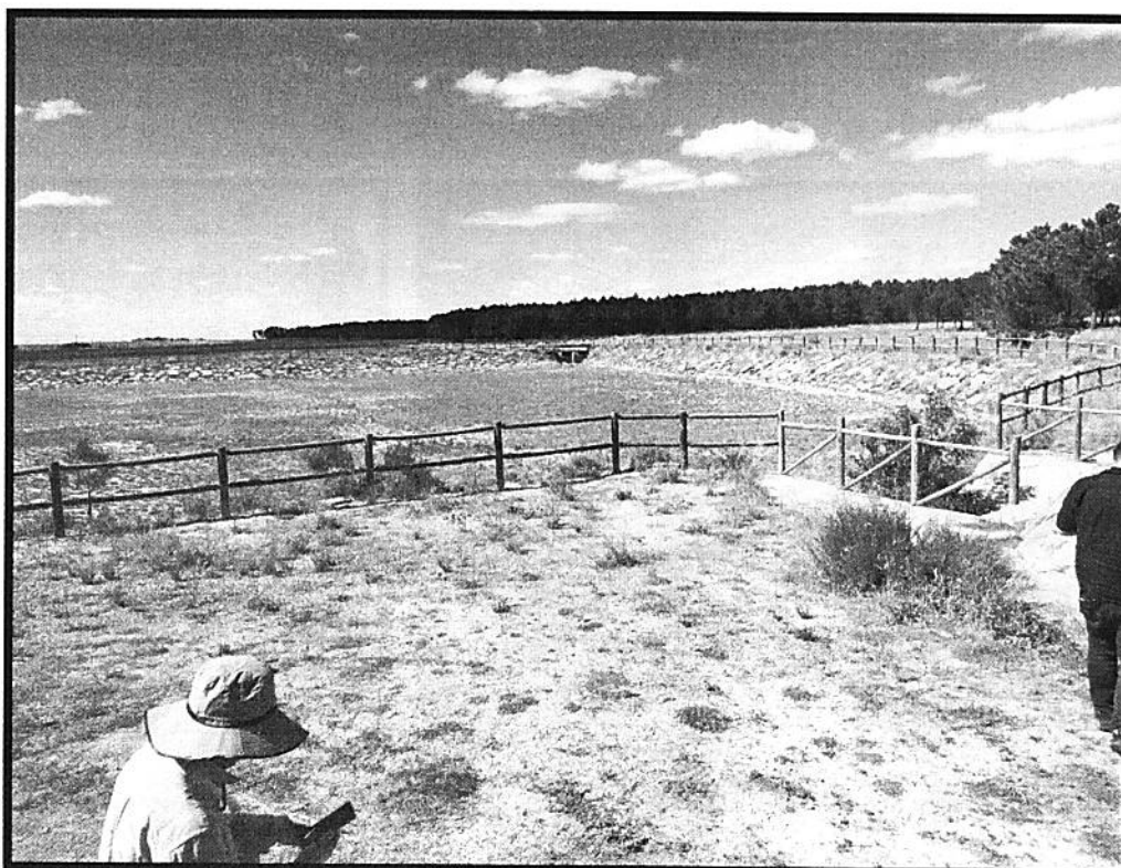
Anexo 4. Laguna de infiltración presentada durante en la visita técnica 3 del ISMAR10
