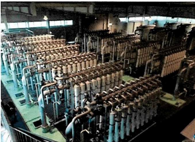
Foto 8: Planta compacta de filtración por membranas. Gongju. TORAY – tecnología creada en USA en 1993 y adoptada por Japón. En Corea se usa desde el 2009.
