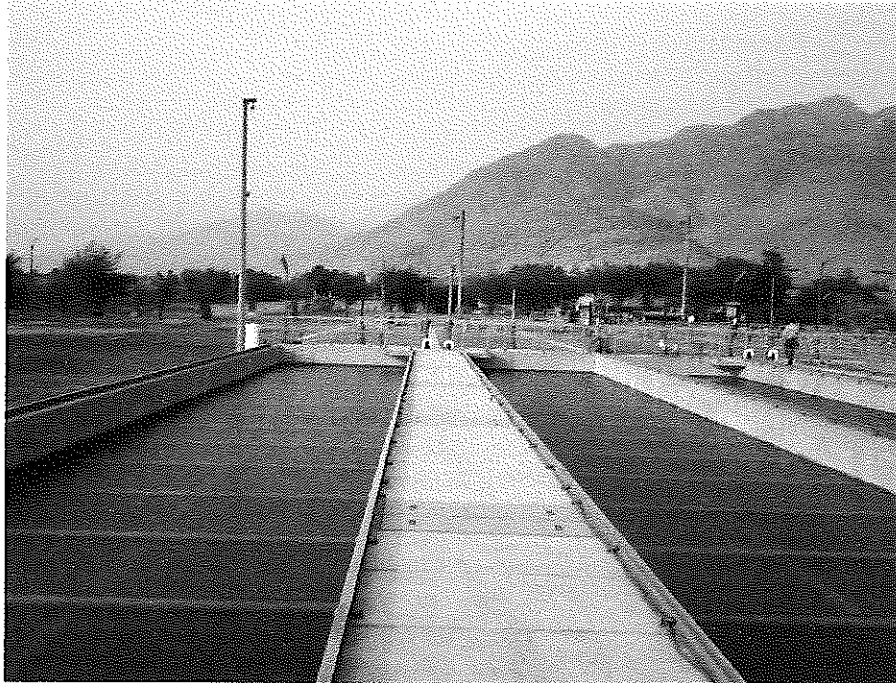
Figura 9. Vista de los decantadores
