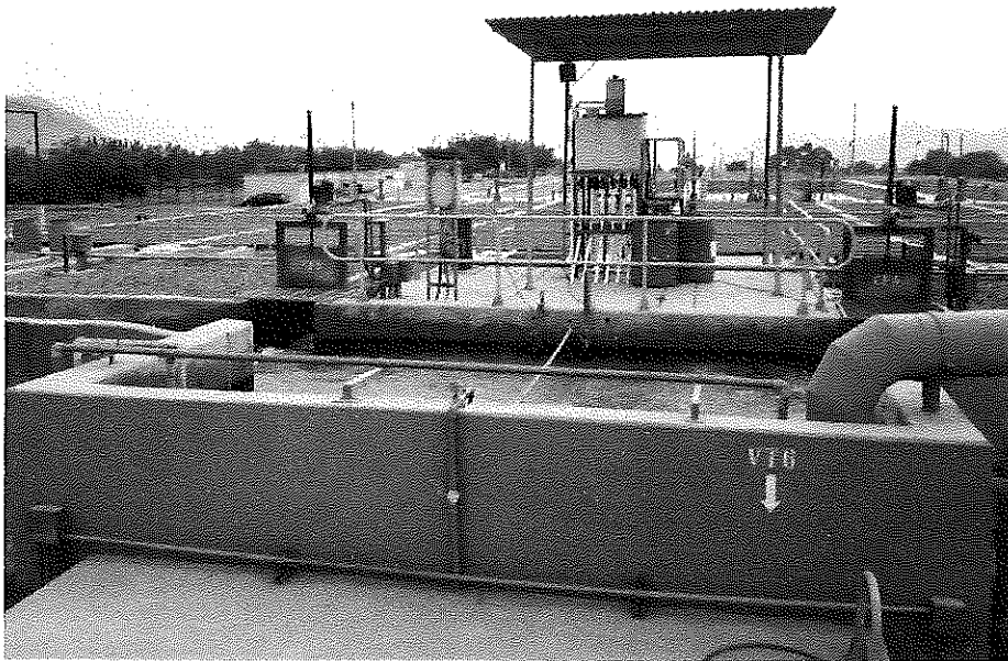
Figura 4. Cámara de entrada hacia los 6 Parshall Fuente: Propia, 2016
