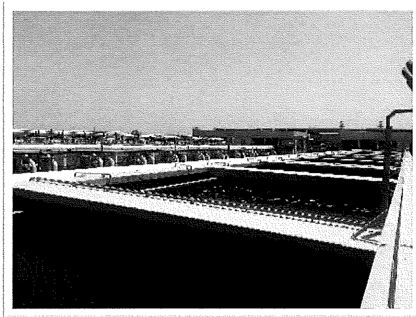
Imagen #4: Filtros duales, etapa de pretratamiento. Planta Sorek.
