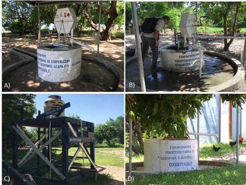
Fig 2. Pozos construidos por CODEFAGOLF en Isla Boca de Río Viejo: A) Pozo ubicado en casa del Señor Salomé Vásquez, B) y C) Pozos ubicados en la escuela y D) Pozo ubicado en campamento Boca de Río Viejo.
