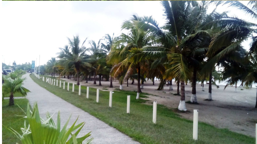
Inspecciones en Playa Municipal de Tela
