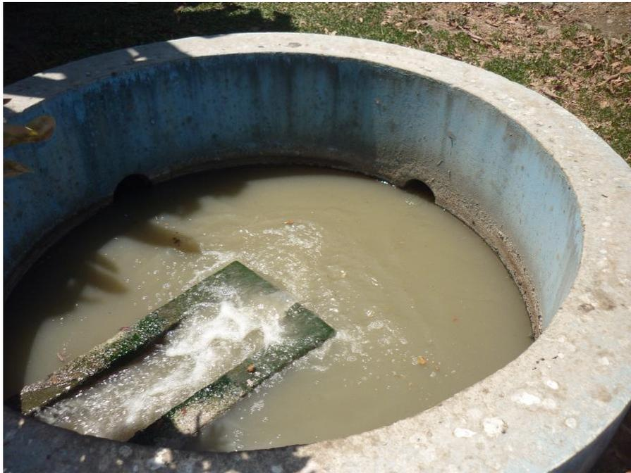
**Figura 37:** Segunda cámara de distribución de caudales
