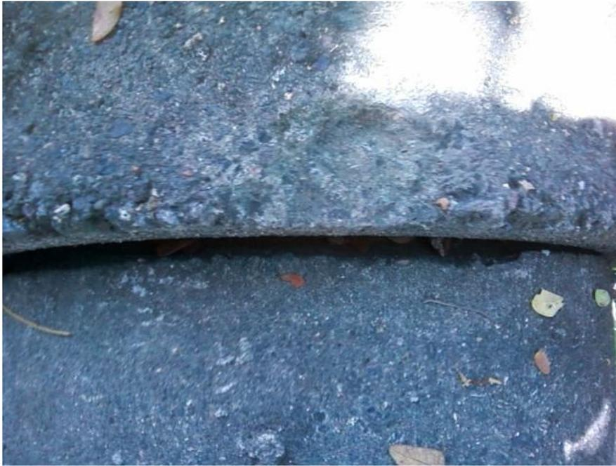
**Figura 33:** Abertura expuesta en una unión en el colector final viejo
