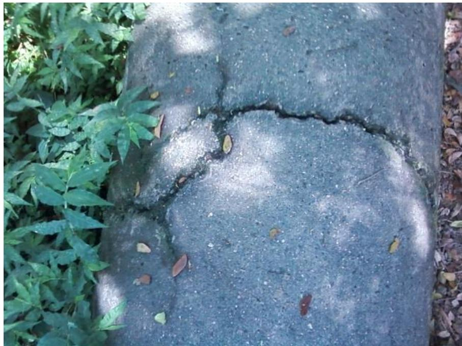
**Figura 32:** Rotura expuesta en el colector final viejo
