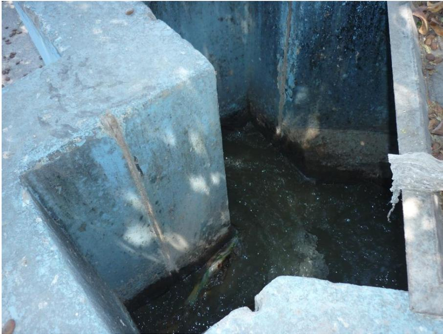
**Figura 36:** Primera cámara de distribución de caudales
