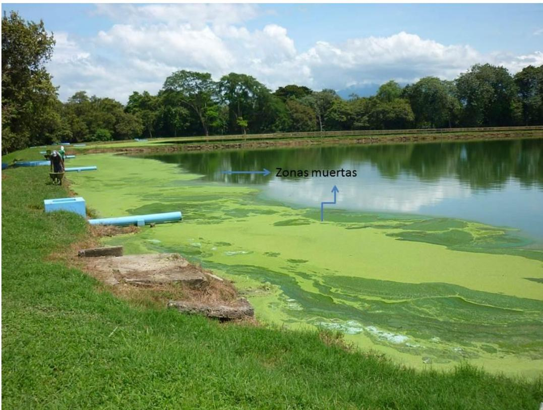
**Figura 42:** Problemática del mantenimiento de la PTAR.
