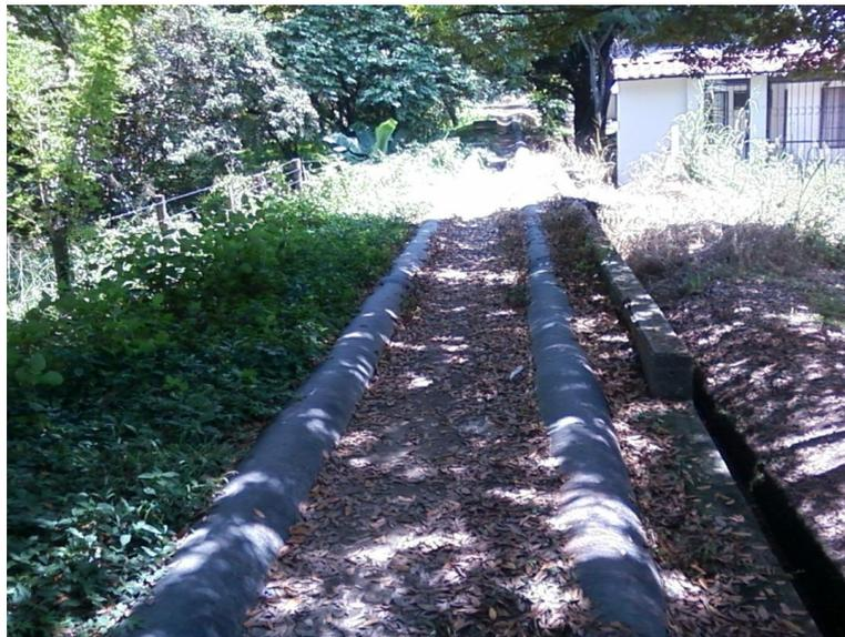
**Figura 30:** Colector final actual, a la izquierda y colector final antiguo a la derecha.
