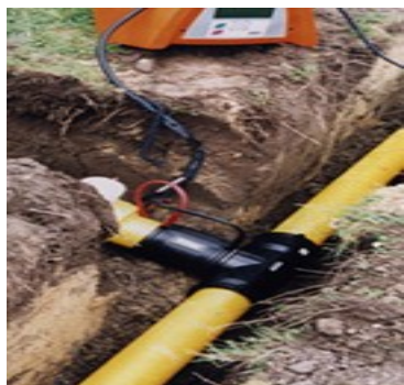
Foto 1: Proceso de Electrofusión
